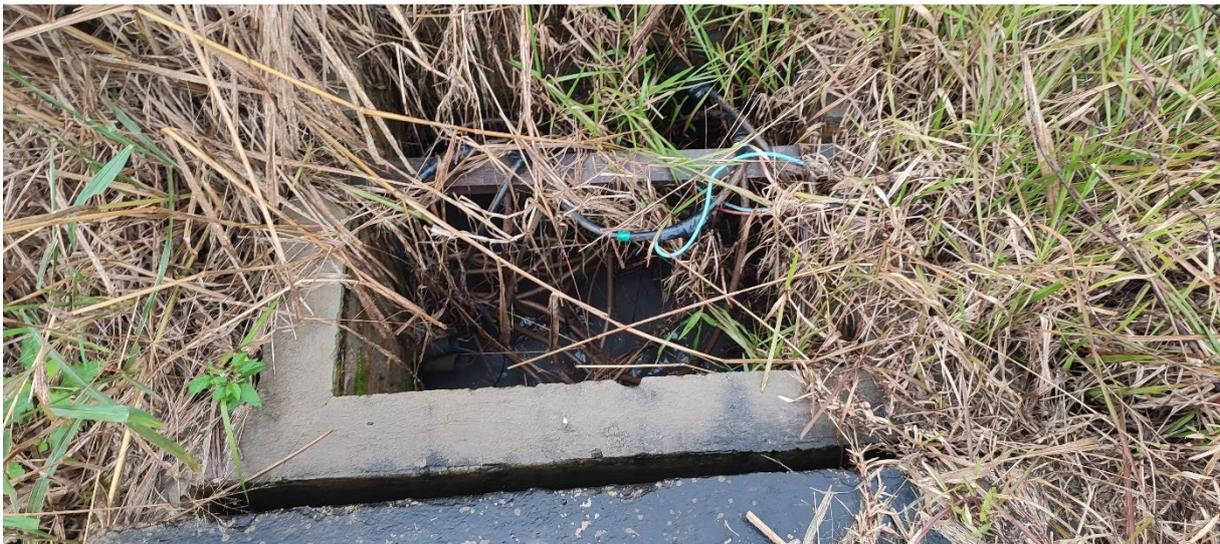
*Abbildung 13: üblicher Anschlusskasten eines Grundstückes, an welchen die Strom- und Wassersäule des Gebäudes angeschlossen wird*
